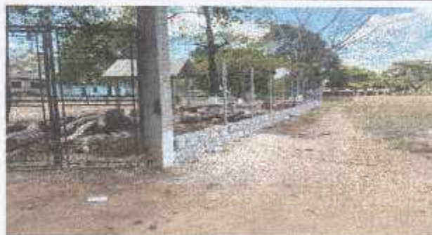
Foto 6: Se observa la colocación de los tubos galvanizados en la parte frontal del área perimetral.
