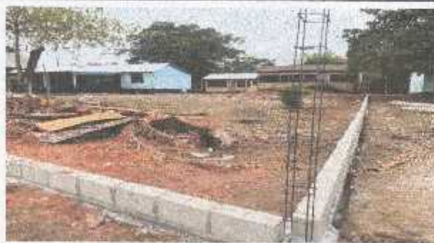
Foto 5: Se observa la colocación de las hiladas de block y la columna de concreto a un costado del área perimetral.
