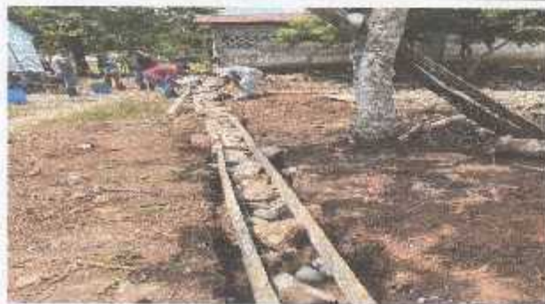
Foto 3: Se observa la colocación de piedras para el cimiento del área perimetral de la escuela.
