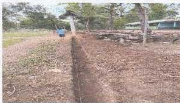
Foto 2: Se observa la realización del sanjeado para la cimentación del predio de la escuela.
