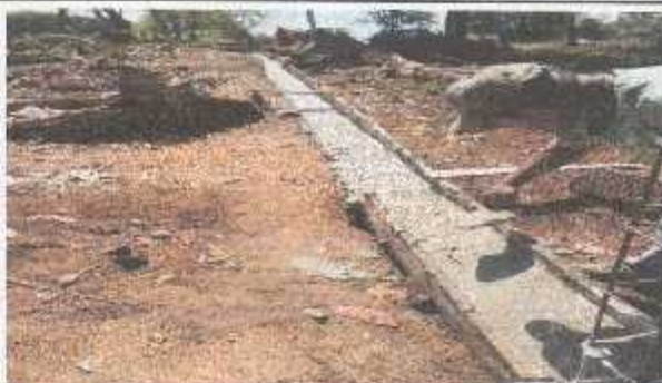
Foto 4: Se observa la colocación del concreto en la cimentación de la parte de atrás del área perimetral.
