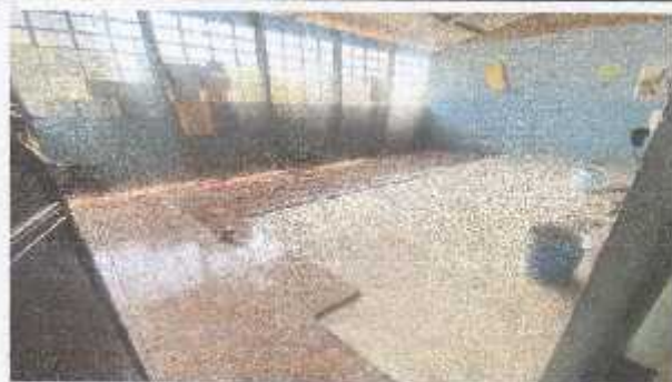
Foto 1: Se observa la colocación del piso cerámico en un aula.
